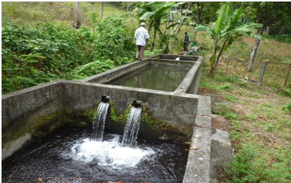
Figure 24 Bassin de décantation et traitement de l'eau de Houngouni
