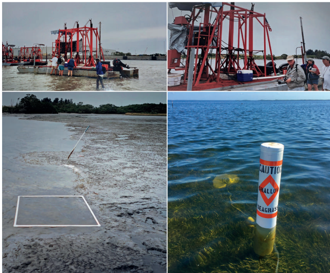
Cadre 6. Travaux de sauvetage et de restauration des herbiers dans la baie de Tampa (Floride) : en haut, giga-dispositif de transplantation de racines. En bas (à gauche) : zone intertidale où des mottes d'algues de 1x1 m ont été retirées avec la machine ci-dessus (voir cadran pour référence d'échelle). En bas (à droite) : bouées de démarcation utilisées pour prévenir toute entrée, transit, ancrage ou dérive dans les zones restreintes, pour permettre aux herbiers de se remettre des dégâts causés par les bateaux.
